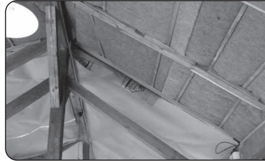
Zateplení střechy domu konopnou izolací THERMO-HANF
