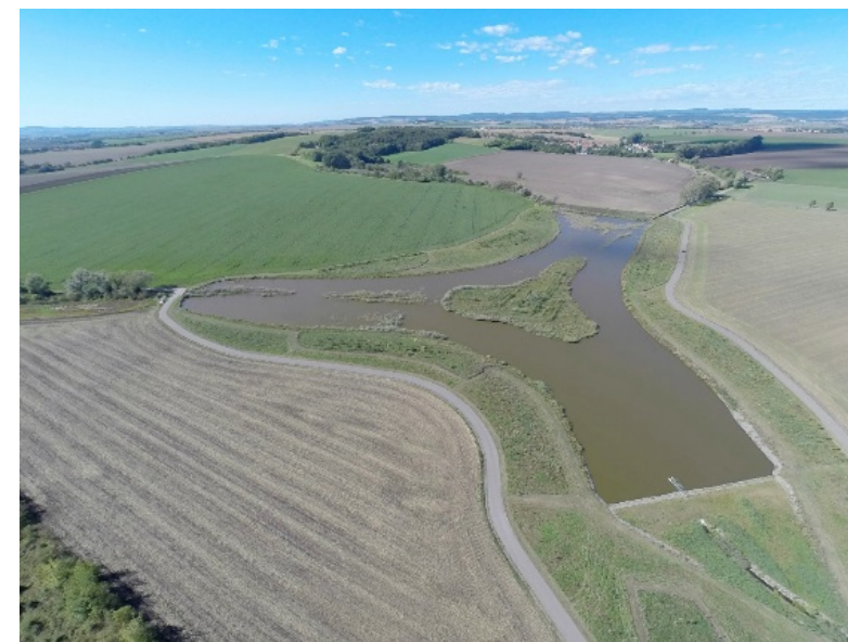
Polní cesty, víceúčelová nádrž a lokální biocentrum LBC 7 v k.ú. Čelčice. Na ostrově a v okolí vodní nádrže je provedena výsadba lokálního biocentra LBC 7. Celkem bylo vysazeno 453 nejen ovocných stromů, 3732 ks keřů a 440 ks mokřadních bylin. Účelem nádrže je zadržení vody v krajině foto: archiv VÚMOP
