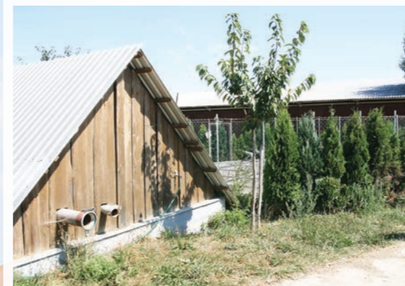
K šetrnému hospodaření s vodou na farmě přispívá podzemní nádrž na vodu, která je rovněž osázená ovocnými stromky.
