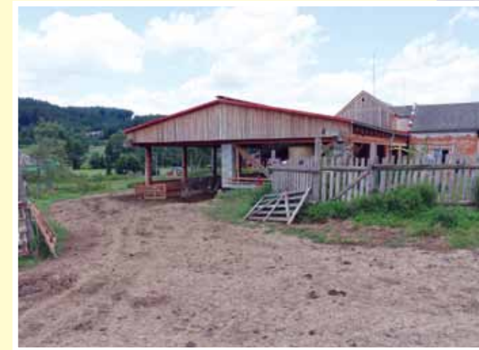
K původnímu statku, který se postupně rekonstruuje, byl přistavěn dřevěný ovčín.
