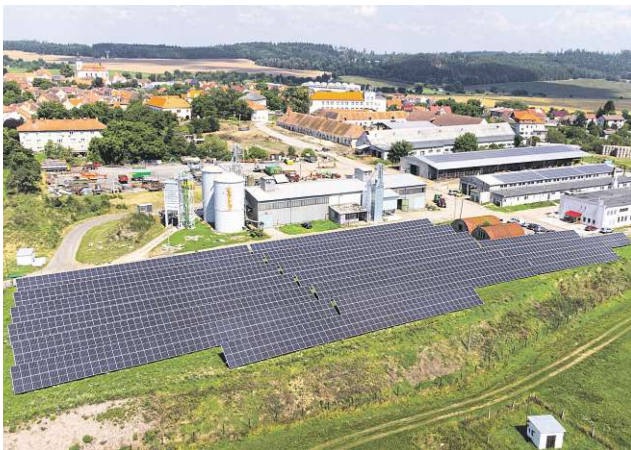
Dokončená fotovoltaická elektrárna zemědělské společnosti AGRO Sedlice.
