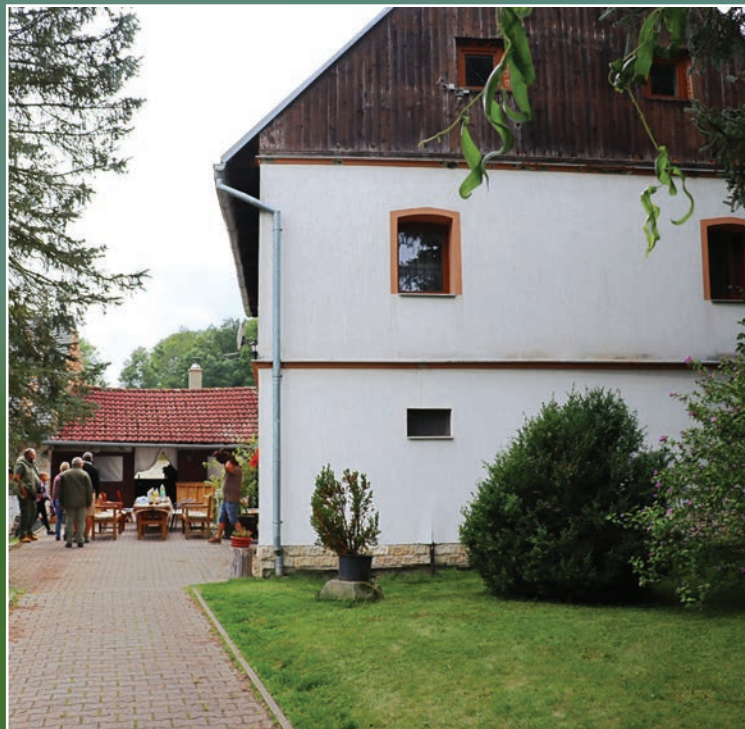
Areál bývalého Richtrova mlýna nedaleko Lovečkovic bude po rekonstrukci sloužit k ubytování hostů.
